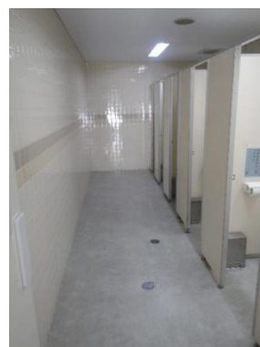
改修後の女子トイレ
