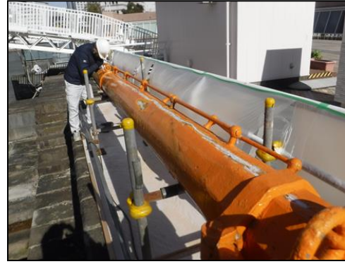
木製ヤード補修
