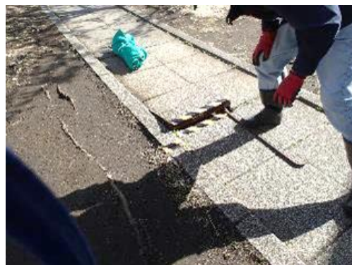
歩道ブロックの段差補修
