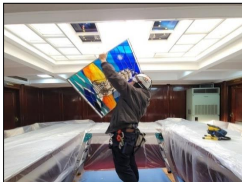
ステンドグラス補修
