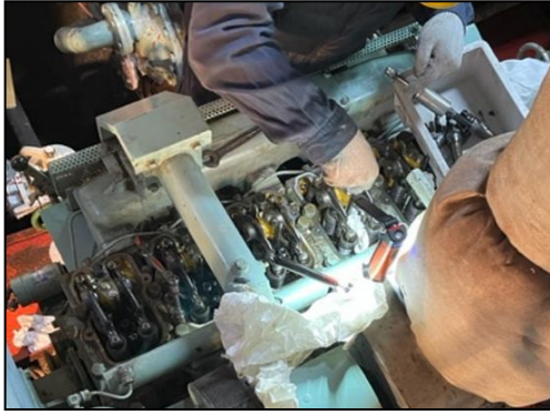
非常用発電機（原動機）開放整備
