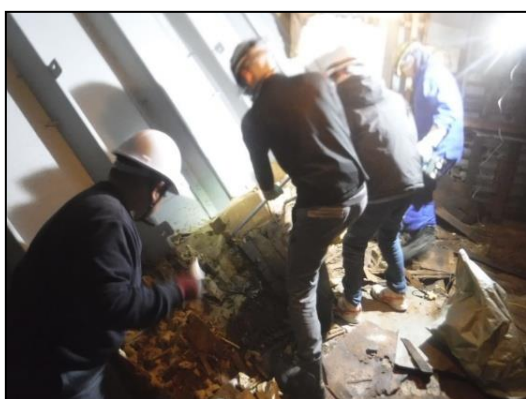
第三甲板旧冷蔵庫内壁面及び床面補修
