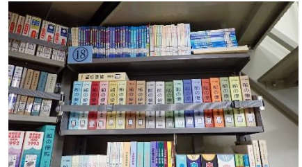
書庫内書架への落下防止ベルト取付状況
