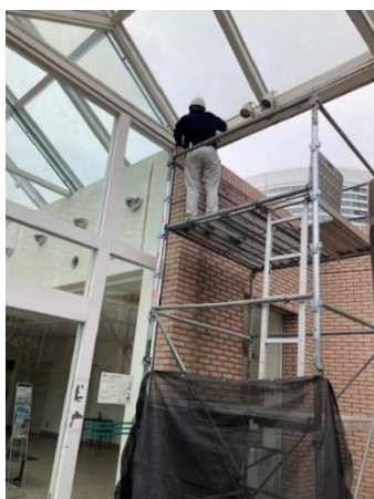
訓練センターの漏水修理
