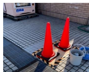
タイルの応急措置
