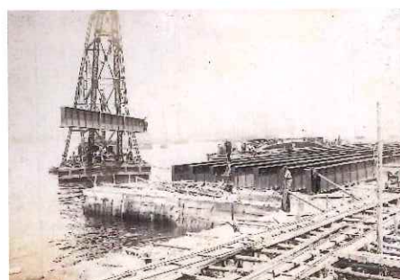
(写真A)横棧橋の橋脚の上に据え付けられるガーダー
