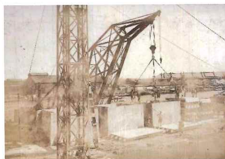
(写真B)8号岸壁に置かれる鉄筋コンクリートケーソン
