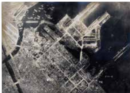
上空から見た横浜港の被災状況 1923(大正12)年 『関東震災地写真帖』より 新港ふ頭では上屋が焼け落ち、岸壁が崩れている。 大さん橋は一部を残して崩落した
