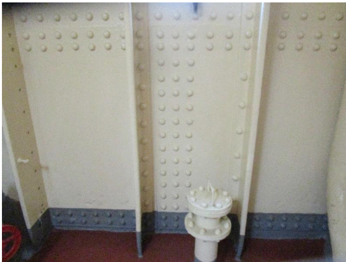
船内のリベットの様子
