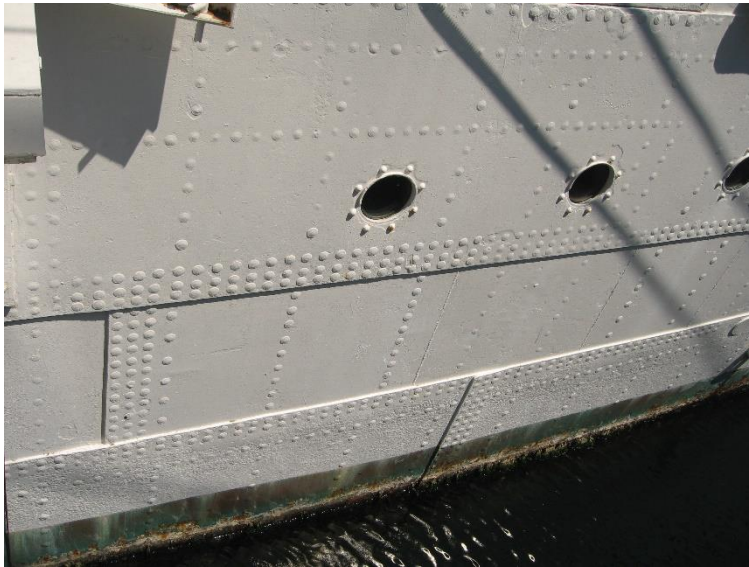
船外から見たリベットの様子
