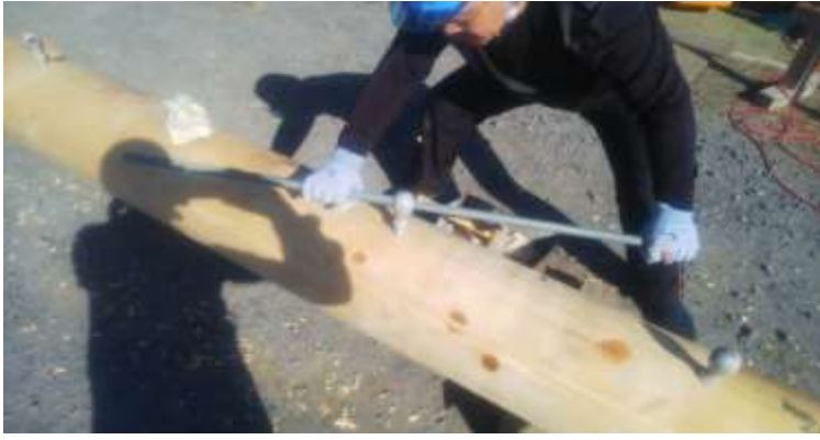
工事名： 帆船日本丸LGヤード改修工事 工程名： 金物取付作業 撮影日時： 2021年1月16日
