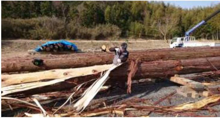
工事名： 帆船日本丸LGヤード改修工事 工程名： 皮むき作業 撮影日時： 2020年1月14日
