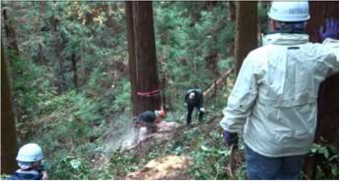
工事名： 帆船日本丸LGヤード改修工事 工程名： 原木伐採 撮影日時： 2019年11月27日
