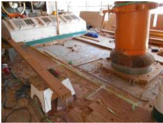
各部木甲板交換・漏水部補修
