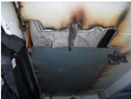
凹甲板防災センター床下補修
