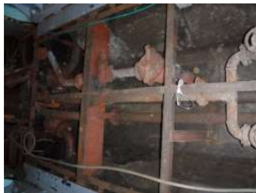
機関室内タンクトップ塗装
