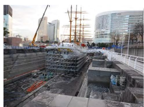
外板補修及びリベット摩耗箇所補修
