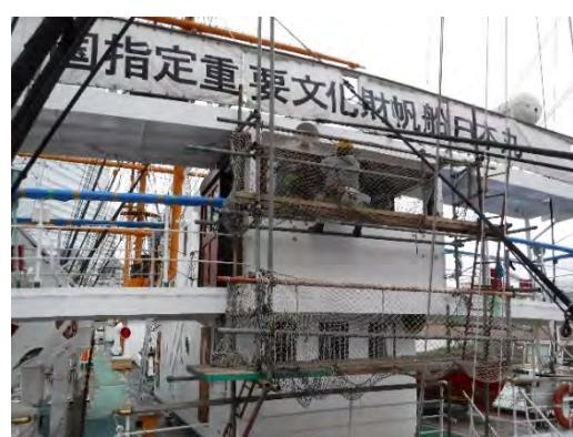
船橋全面窓枠周り鋼壁補修
