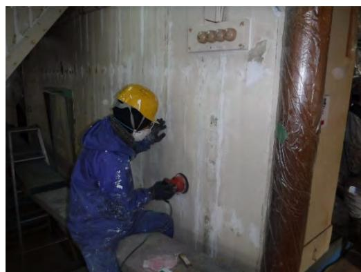
中部エントランス付近天井・漏水部・鋼壁補修
