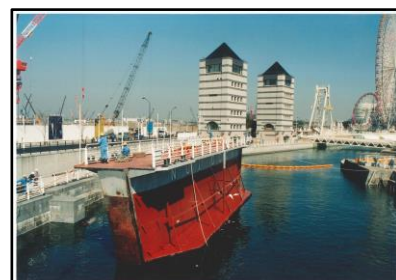
補修のため浮上させた扉船
