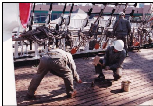
チーク材の継ぎ目へのオーク材打ち込み作業
