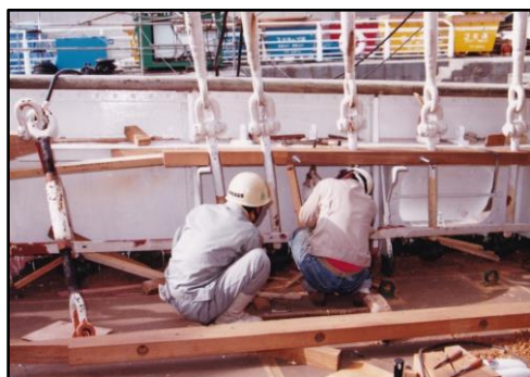
長さ14メートルのピン・レイルの取り換え工事
