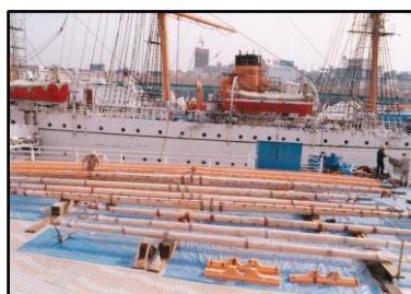
木製ヤードの塗装作業
