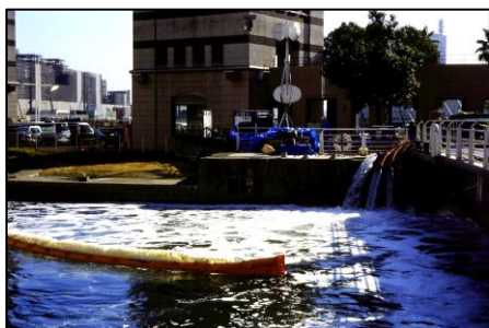
ポンプで汲み上げた海水は、ドックの外へ排水
