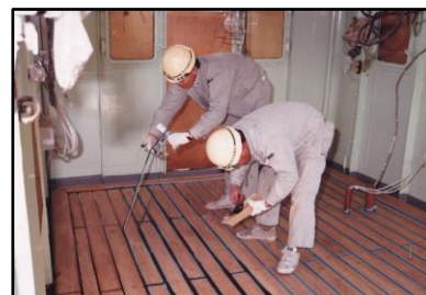
操舵室木甲板の張り替え
