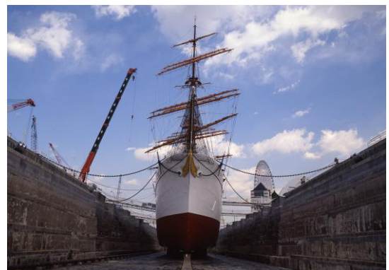
平成 3 年（1991 年）の大規模修繕工事状況
