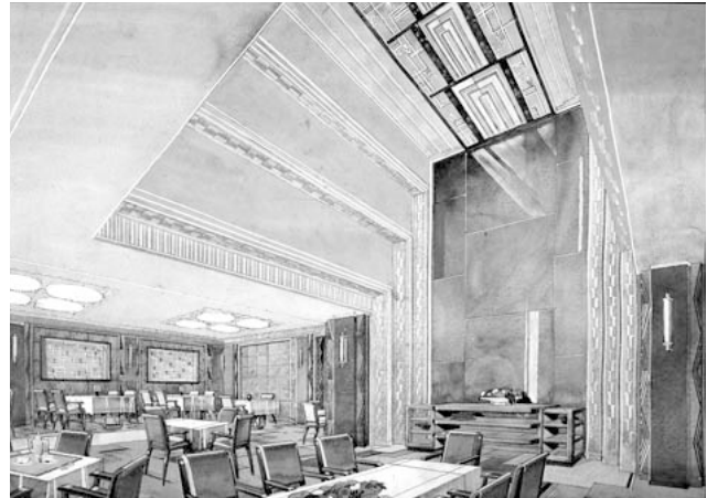
氷川丸1等食堂 マルク・シモンが設計したアール・デコのインテリア。この計画通り施工された。現在は改装されているが、柱や照明器具などに往時の姿を見ることが出来る。1928～29（昭和3～4）年 三菱重工業（株）原動機事業本部横浜製作所蔵
